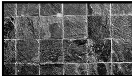
**Fig.39/40** - Controllare la solidità e l'ancoraggio del sottofondo. Devono inoltre essere eliminati tutti i residui di oli, grassi e cere con un lavaggio con acqua e soda caustica seguito da un appropriato risciacquo. Nell'impossibilità di effettuare la pulizia chimica, procedere all'abrasione meccanica.
