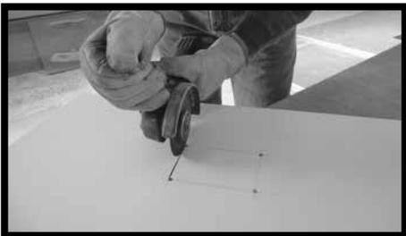
**Fig.19** - Per la realizzazione di tagli interni e a "L" si consiglia di arrotondare i vertici dell'apertura utilizzando punte con raggio di almeno 5 mm per ridurre il rischio di provocare rotture. Quindi procedere con il taglio con dischi diamantati avendo l'accortezza di interrompere l'avanzamento una volta raggiunto il foro precedentemente realizzato. Per l'esecuzione della foratura e del taglio con dischi diamantati seguire le indicazioni riportate precedentemente.
