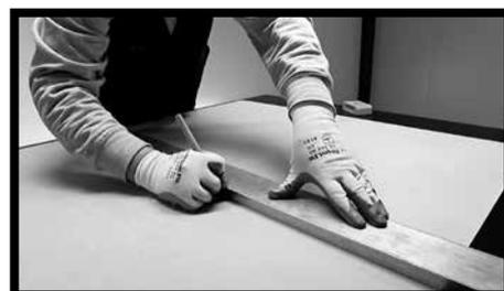
**Fig.10** - Per rendere un'incisione la più rettilinea possibile si può ricorrere all'ausilio di stagie in alluminio comunemente usate dai muratori.
