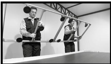
**Fig.4/5** - Le lastre di SLIMTECH nelle sue varie tipologie nel formato 300x100 cm possono essere movimentate da due persone con l'ausilio di un apposito telaio. Fissare il telaio alla lastra quando è ancora all'interno del pallet. Quindi sollevare il telaio e la lastra per eliminare l'effetto ventosa.
