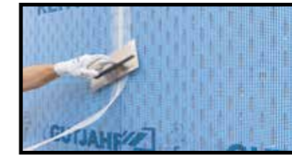
Applicazioni Watec ST - rete di giuntura
