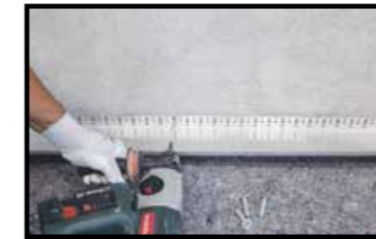
Posizionamento dei profili di partenza MAPETHERM BA
