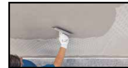
Rasatura di adesione
