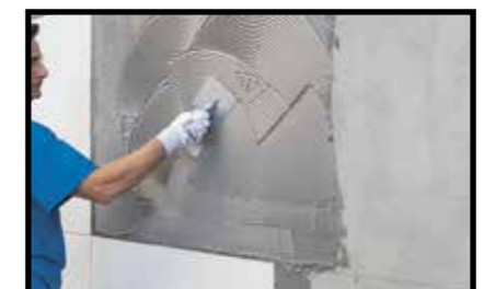
Doppia spalmatura (muratura)
