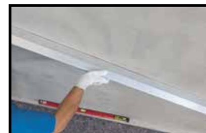
Controllo planarità dell'intonaco strutturale
