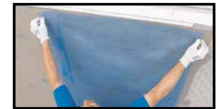
Stendere rete armatura CeraVent
