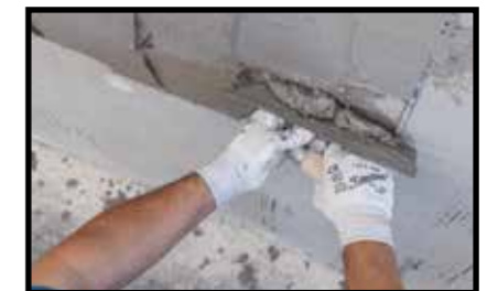
Secondo strato PLANITOP HDM MAXI
