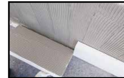
Posa dei pannelli isolanti con doppia spalmatura
