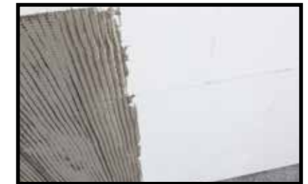
Applicazione primo strato PLANITOP HDM MAXI
