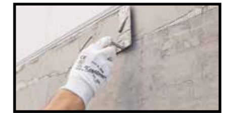
Posizionamento del profilo con annegamento della retina
